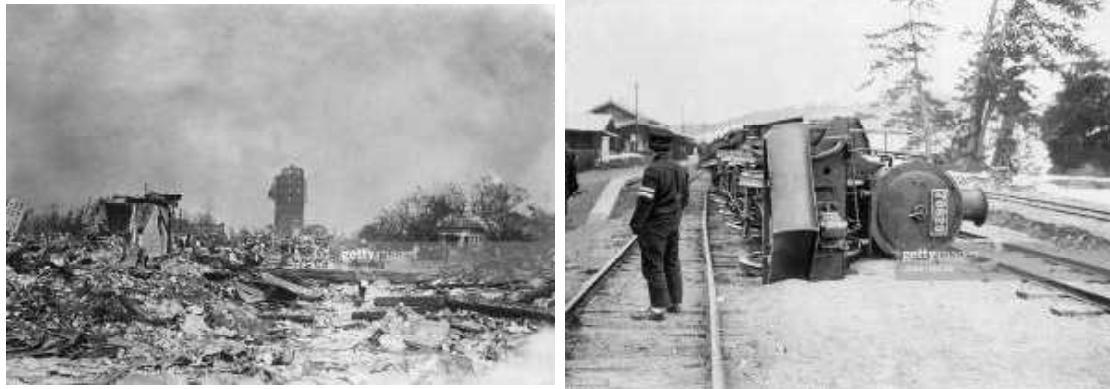
(関東大震災での被災の様子)
